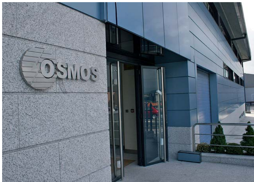
Osmos ha inaugurado hace unos meses una gran nave en el polígono de Alvedro.
