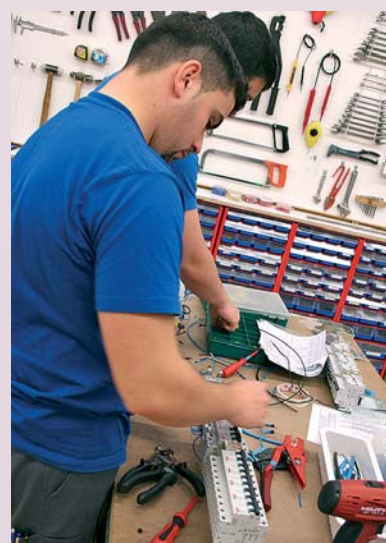
Operarios de Osmos en pleno trabajo.
