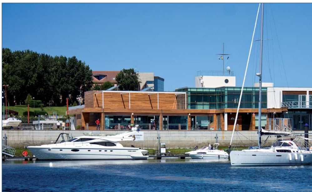
Imagen de las instalaciones contruidas por Abeconsa en el Puerto Deportivo de Marina Coruña.
